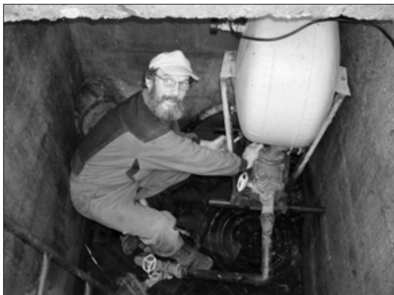
Došlo k výměně tlakové nádrže na pitnou vodu v čp. 115. Foto E. Trísková
