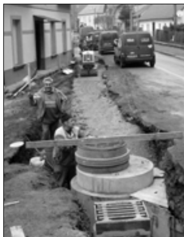
Mnohaleté úsilí o odkanalizování části Bud do Rakovnického potoka bylo konečně zrealizováno. O stavbu usilovali již bývalí starostové. Jako akcí Středočeského kraje stavbu provedla firma ČNES Dopravní stavby, a. s., velkou zásluhu na provedení má Jaroslav Antoni.
