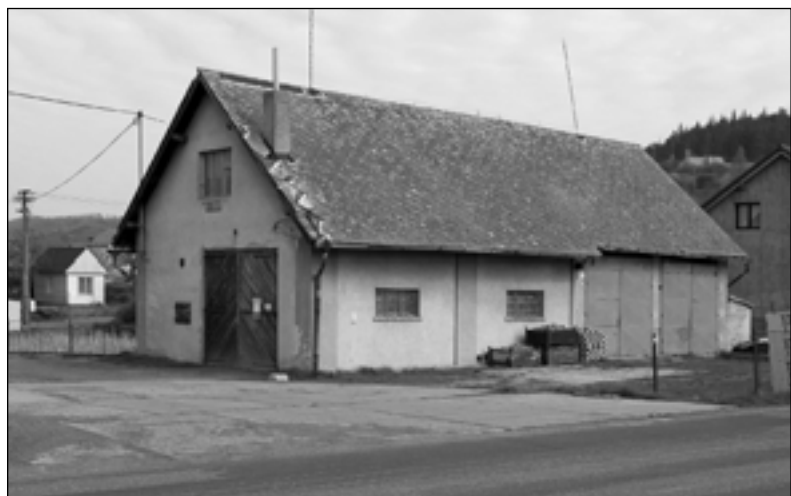
V místě stávající dosluhující hasičské zbrojnice se plánuje výstavba nové budovy. Ta by sloužila jak hasičům, tak záchranné službě. Do okolí zbrojnice se již začíná navážet stavební materiál, neklamná známka toho, že výstavba nové budovy se blíží. Foto Pavel Frieberť
