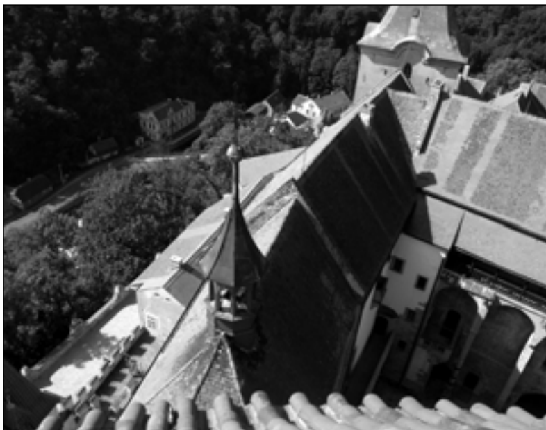
Pohled na střešní trakt jižního křídla hradu, který letos projde velkou obnovou.
