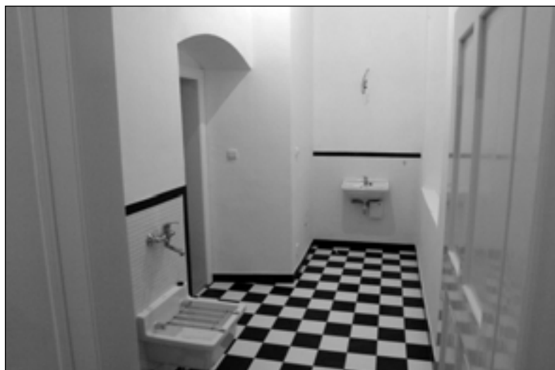
Budova Hejtmanského domu prochází postupnou obnovou. Rekonstrukcí historických toalet získala správa hradu již důstojné sociální zařízení.
