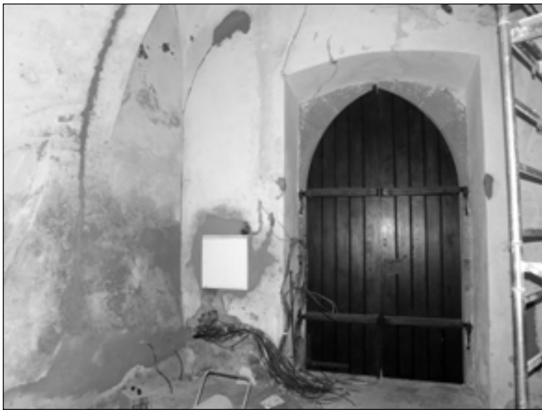
Galerie LEDNICE – probíhající oprava...
