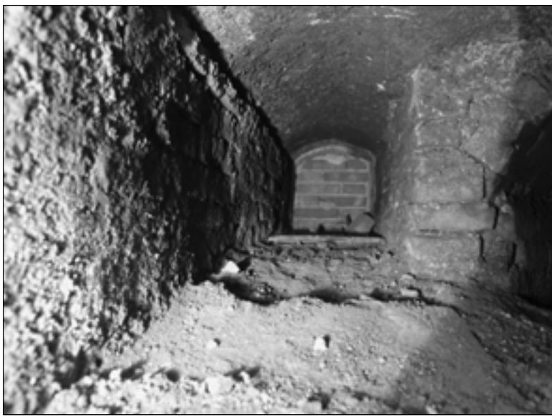
Pravděpodobně soustava větracích šachet Hejtmanského domu. Při rekonstrukci vnitřních prostor došlo k zajímavému nálezu soustavy větracích otvorů mezi jednotlivými prostory lednic.
